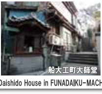
船大工町大師堂 Daishido House in FUNADAIKU-MACHI
